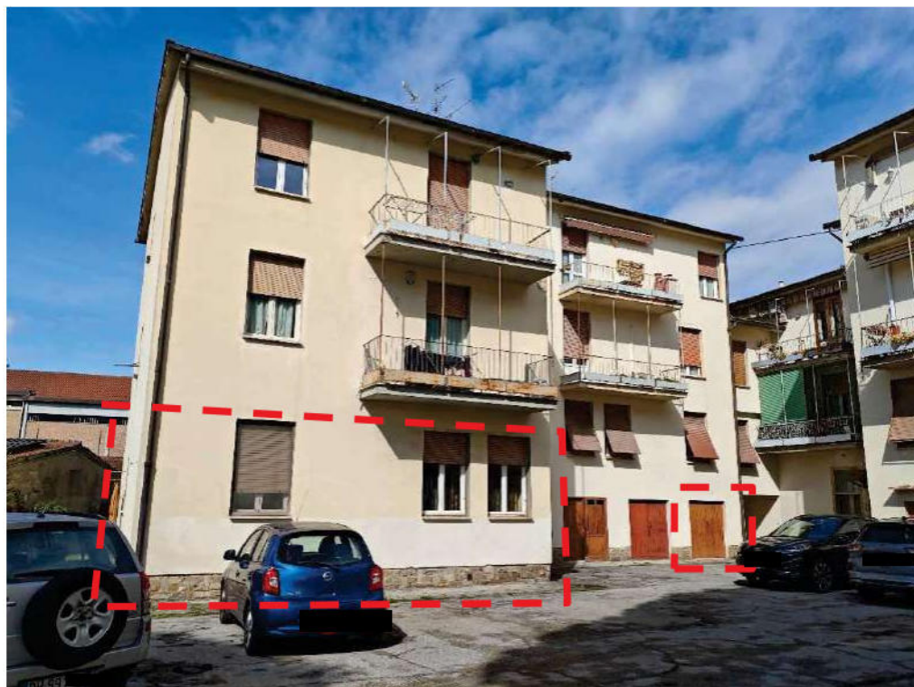
FOTO 5 Vista dal resede a comune - fianco est
