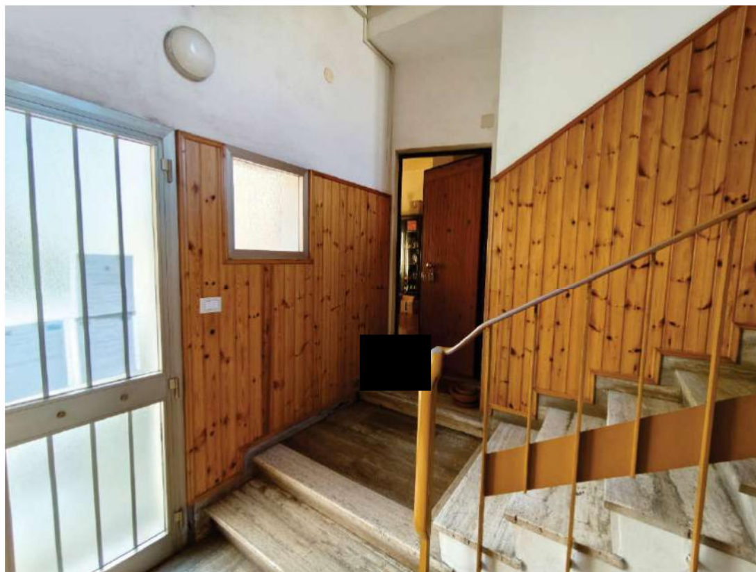
FOTO 9 Accesso all' abitazione dal vano scala condominiale
