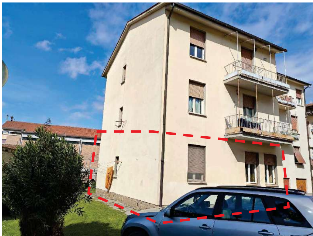
FOTO 7 Fianco sud ed est ripresi dal resede a comune
