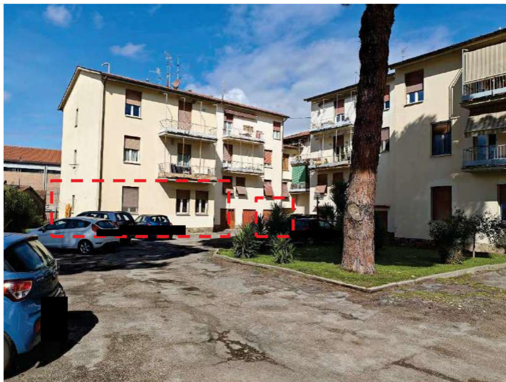
FOTO 3 vista dal resede a comune interno - prospetto est
